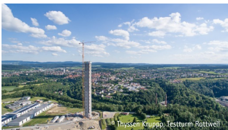
Der neue Thyssen Krupp Testturm in Rottweil soll zum Besuchermagneten werden.
