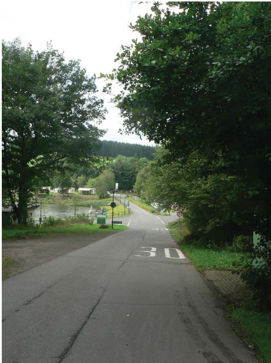
Abbildung 4 : öffentliche Gemeindestraße; Damm zwischen Freizeitsee und Rezeption des Parks Landal Wirftal (Blick Richtung Kreisstraße 67)
