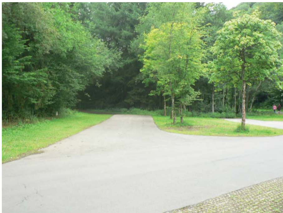
Abbildung 6: Parkflächen, in der Aufweitung der Gemeindestraße
